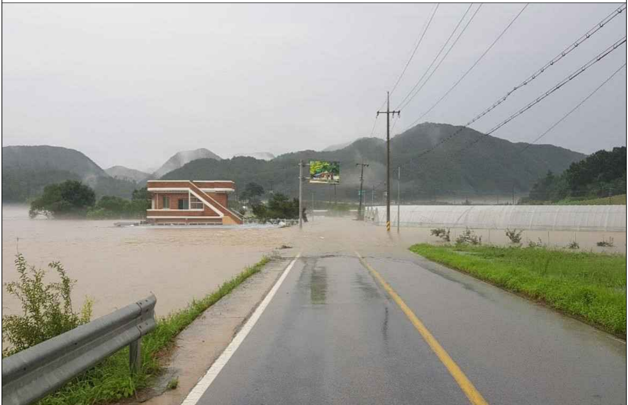
용서천(소) 월류에 의한 가옥 및 농경지 침수
